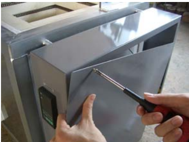
⑯ 配電函のヒーター線がケーブルや端子以外の金属に接していないことを確認し、カバーを取り付けます
