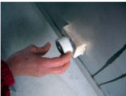
⑲バーナーを抜き取り栓をします
