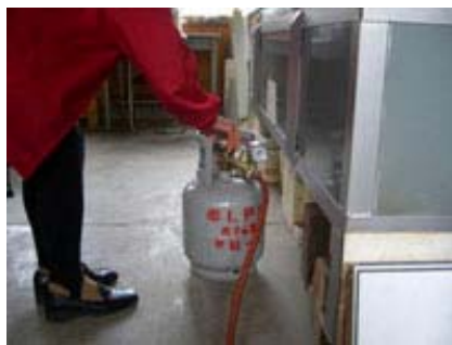
⑰ガスボンベの元バルブを閉め
